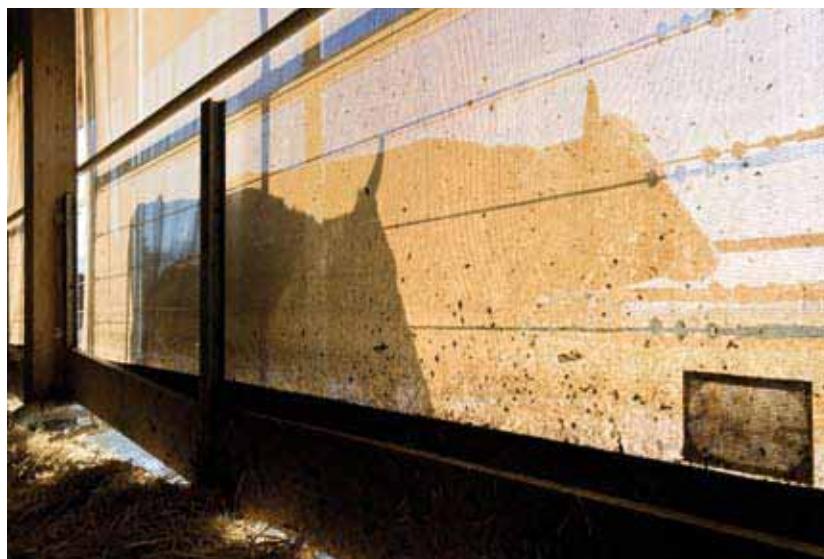
Durante la stagione fredda le reti proteggono dal vento il capannone aperto sui lati della stalla a stabulazione libera nell'azienda Herterenhof.
