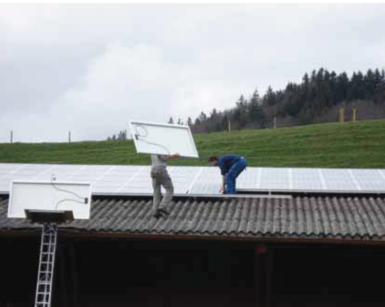
Alla fine di marzo 2008 sono stati montati sul tetto della stalla e del fienile 160 metri quadri di moduli solari.
