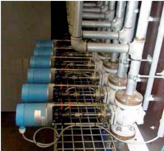
Grazie ai dosatori computerizzati giunge nel silo sempre la giusta quantità di aria povera di ossigeno.
