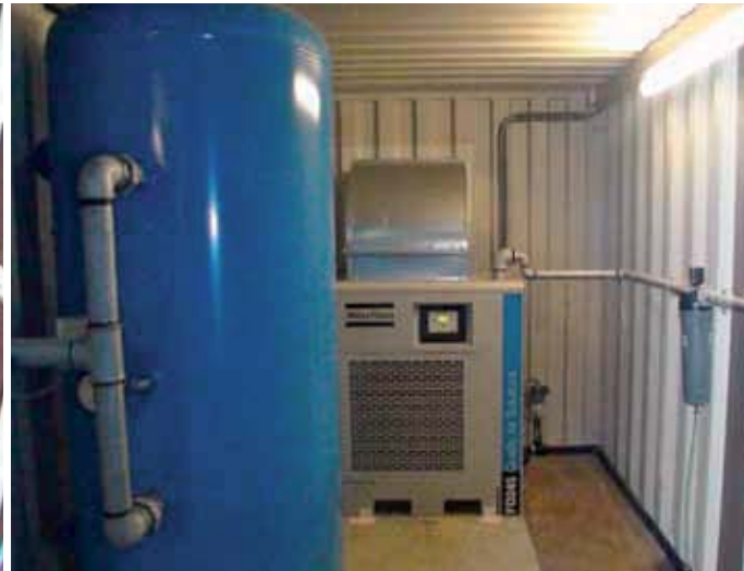
Il centro dell'impianto EcO 2 di Silo Olten. Dietro al recipiente a pressione c'è un deumidificatore per impedire la formazione di eccessiva umidità dell'aria nel silo.
