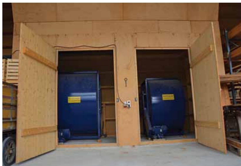
I ventilatori aspirano l'aria che si è riscaldata sotto il tetto in eternit e la soffiano nei due depositi di foraggio
