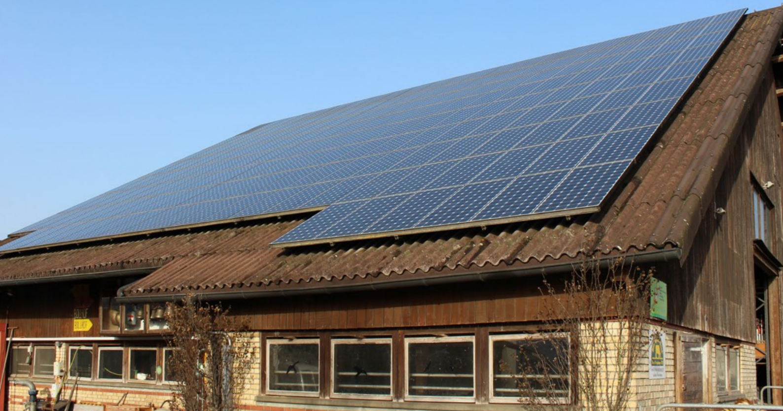
Pannelli solari sul tetto di un edificio agricolo. Foto: René Schulte
