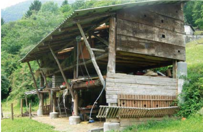
I coniugi Lanfranchi hanno in ampia misura costruito loro stessi questa stalla che funge anche da ripostiglio per gli attrezzi.
