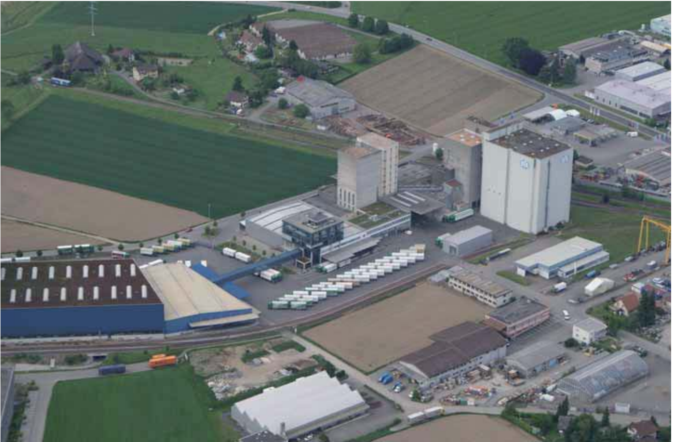
Secondo le proprie indicazioni, la ditta UFA ha investito circa due milioni di franchi nell'impianto Hofmatt a Herzogenbuchsee nel quale trasforma esclusivamente mangime bio.
