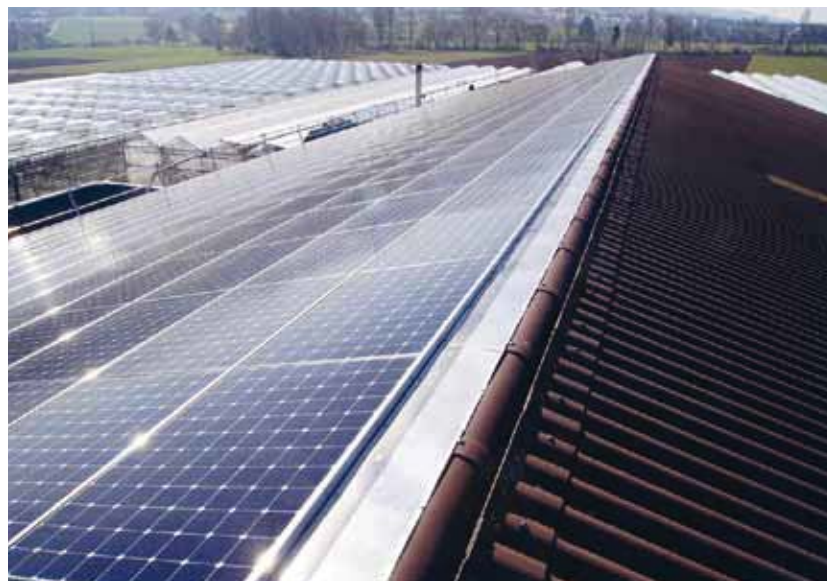
Impianto Fotovoltaico sull'azienda orticola di Stephan Müller, Steinmaur ZH, consegue un rendimento massimo di 174,72 kWp su 893 m 2 .
