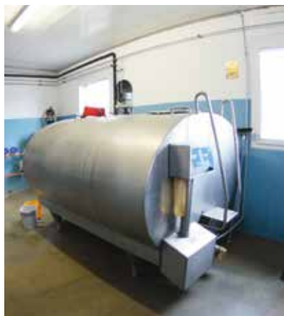
Per grandi serbatoi di refrigerazione del latte e per le aziende che allevano maiali è consigliabile un impianto di pompe di calore.
