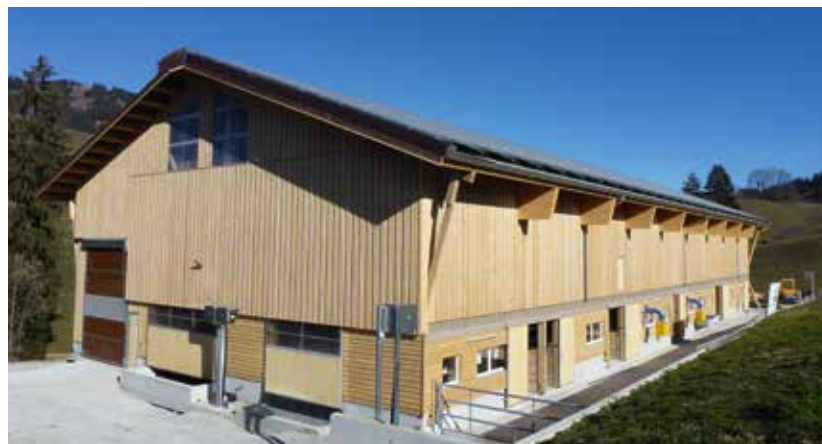
Il calore residuo di impianti fotovoltaici può essere usato per l'aerazione del fieno.
