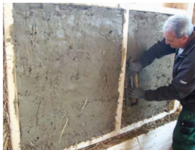
Isolamento in paglia di spelta intonacato con argilla. Foto: mad
