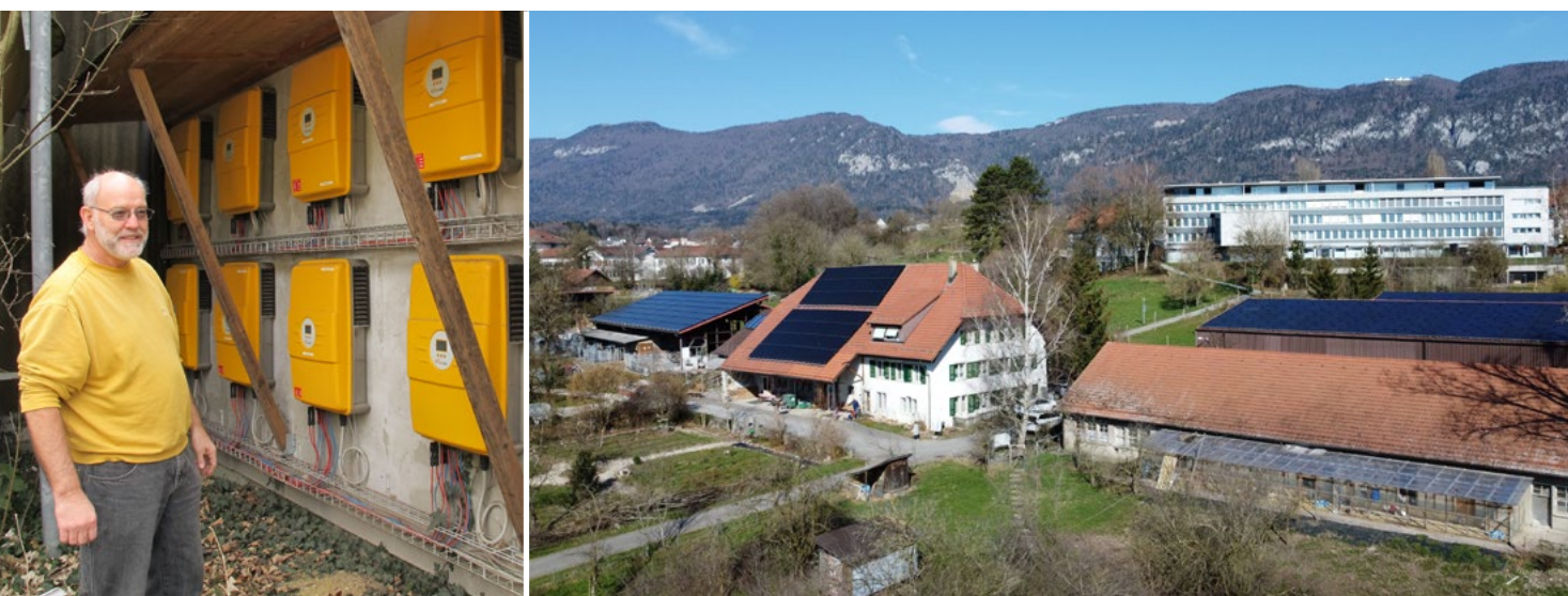
Martin Riggenbach ha installato nella sua azienda un impianto fotovoltaico collettivo e uno a uso proprio sulla sua casa (al centro). Foto: bgo; mad
